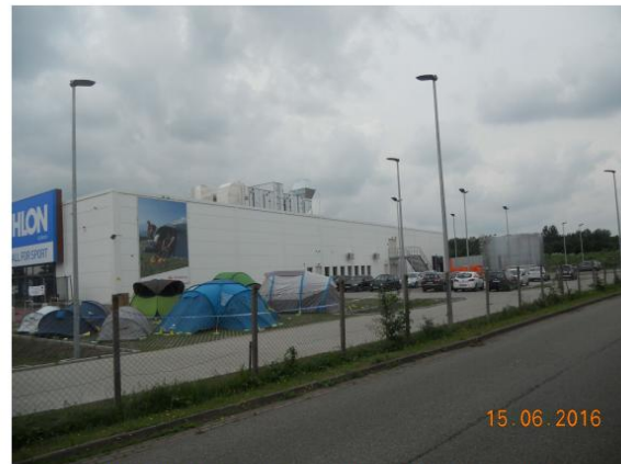
Nord-Ost-Ansicht (Eingang Personal und Technik)
